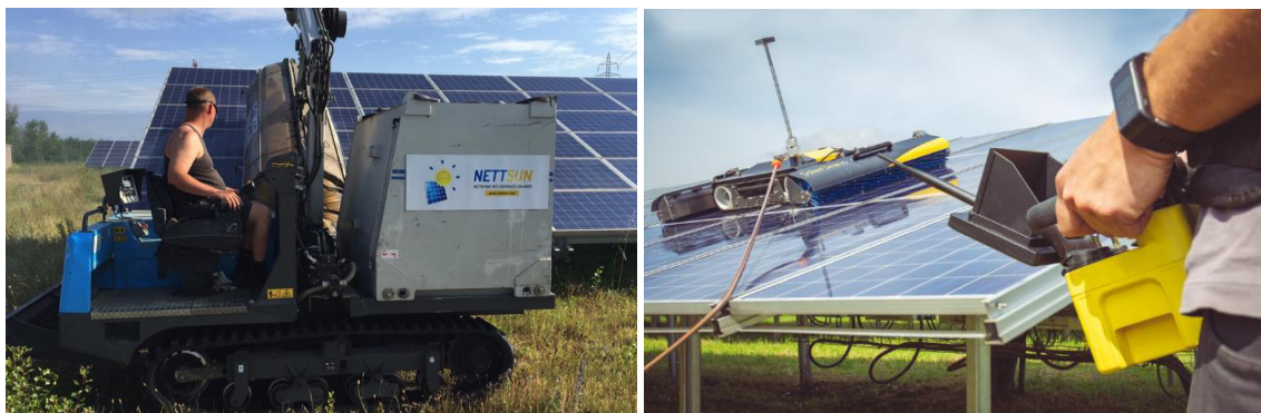
Exemple de technique de nettoyage des panneaux
